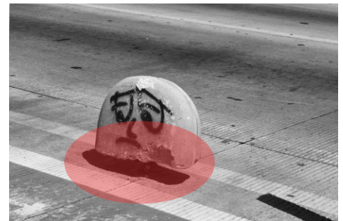
Mal diseño de elementos de confinamiento provoca que deban ser sustituidos ó arreglados a pocos meses de su instalación.
